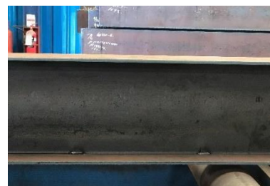
Hasil Tack Welding (Sumber : PT Duta Hita Jaya (Setu))
