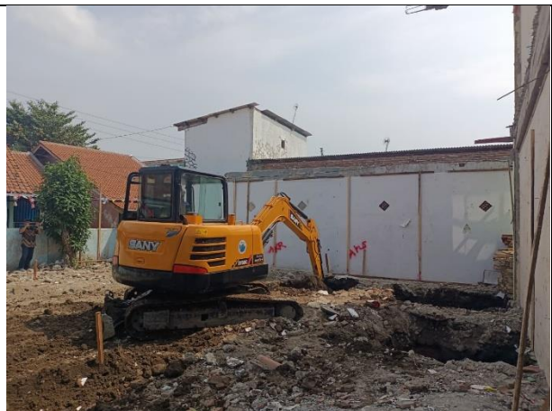
Gambar 2. Pekerjaan Galian Tanah
