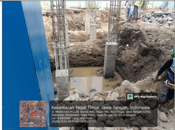
Gambar 4. Bekisting dan Pengecoran
