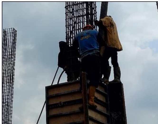
Gambar 2. Pemadatan Beton
