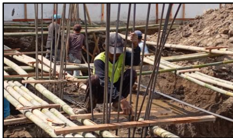
Gambar 1 Pemasangan Tulangan Kolom
