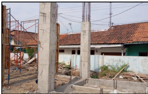
Gambar 4 Hasil Pengecoran Kolom
