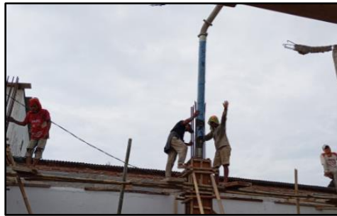
Gambar 3 Proses Pengecoran Kolom
