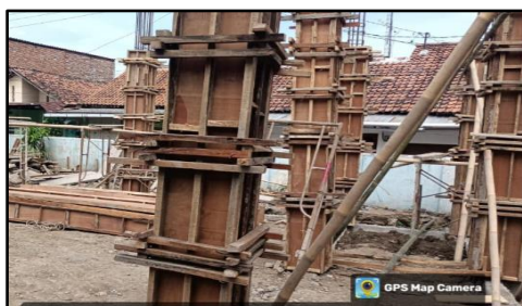
Gambar 2 Pemasangan Bekisting Kolom
