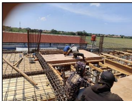
Gambar 2 Pemasangan Papan Multipleks (Sumber : Dokumentasi Pribadi)
