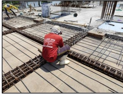
Gambar 3 Pemasangan Pembesian Plat Lantai (Sumber : Dokumentasi Pribadi)
