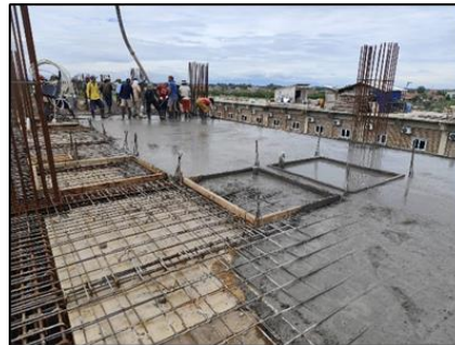
Gambar 8 Penuangan Beton Ready Mix (Sumber : Dokumentasi Pribadi)
