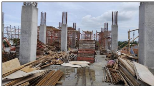
Gambar 1 Pemasangan Scaffolding (Sumber : Dokumentasi Pribadi)
