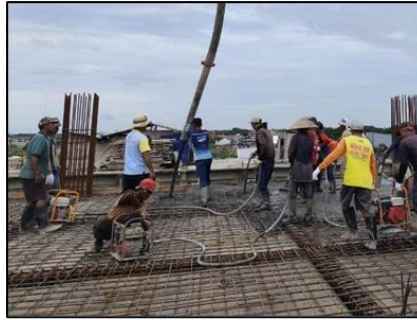
Gambar 9 Pemasangan Menggunakan Vibrator (Sumber : Dokumentasi Pribadi)
