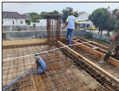
Gambar 5 Vaccum Cleaning Pada Bekisting Plat Lantai (Sumber : Dokumentasi Pribadi)
