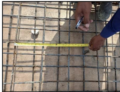
Gambar 4 Pemasangan Pembesian Plat Lantai (Sumber : Dokumentasi Pribadi)
