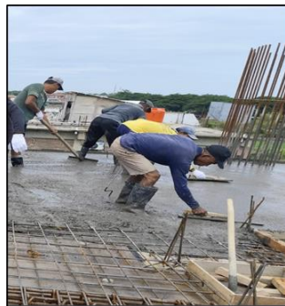
Gambar 10 Perataan Coran Menggunakan Screed Flooring (Sumber : Dokumentasi Pribadi)
