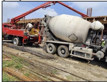
Gambar 7 Pemdistribusian Beton Ready Mix (Sumber : Dokumentasi Pribadi)
