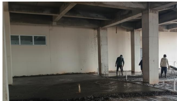
Gambar 1 Pengecoran pelat lantai
